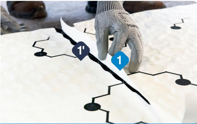
La pose de la dalle suivante se fait de telle sorte que la mèche 1 de la deuxième plaque **recouvre la zone 1'** de la première plaque.
